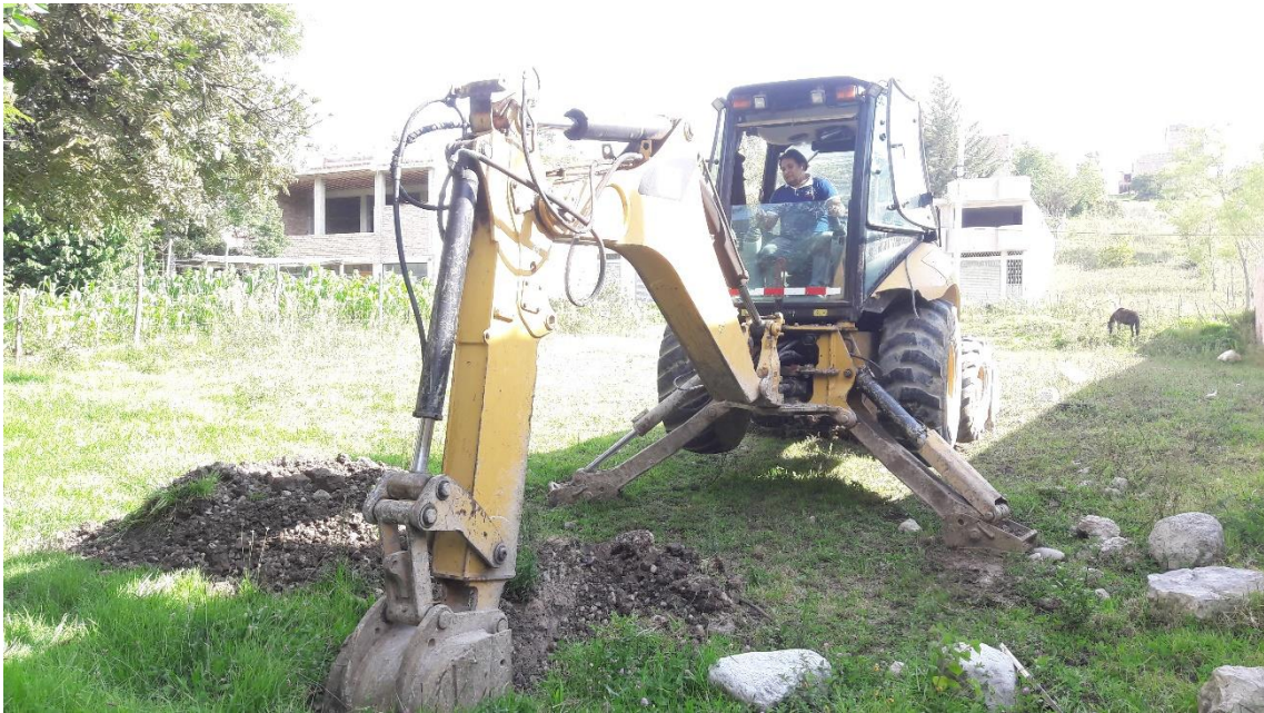
Fotografía N°03: Excavación de la calicata N°04
