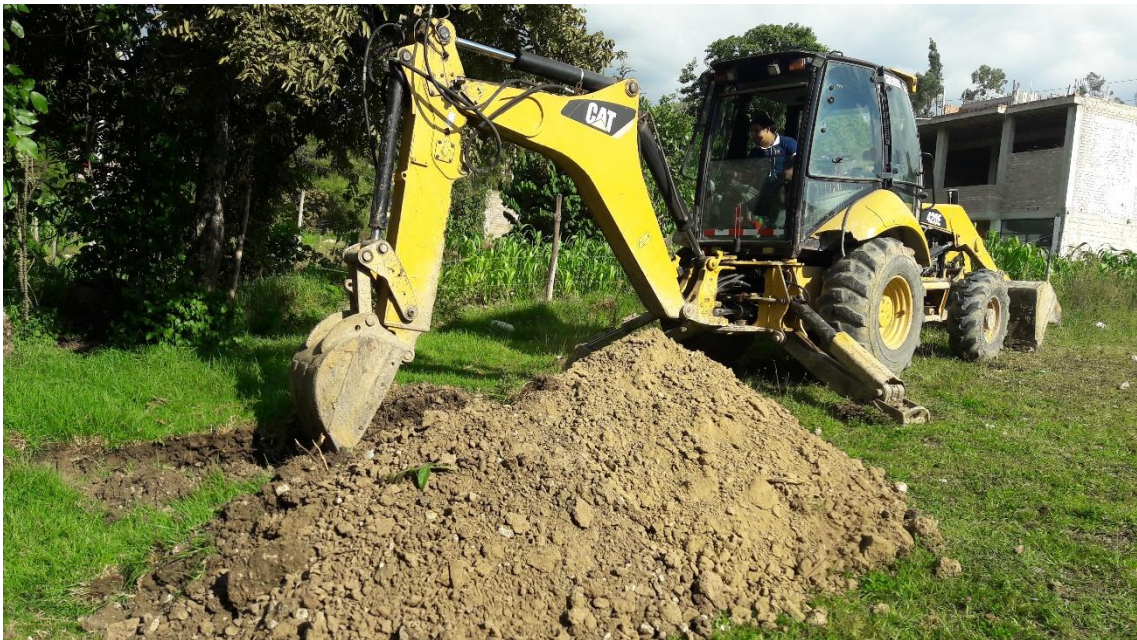
Fotografía N°04: Excavación de calicata N°01
