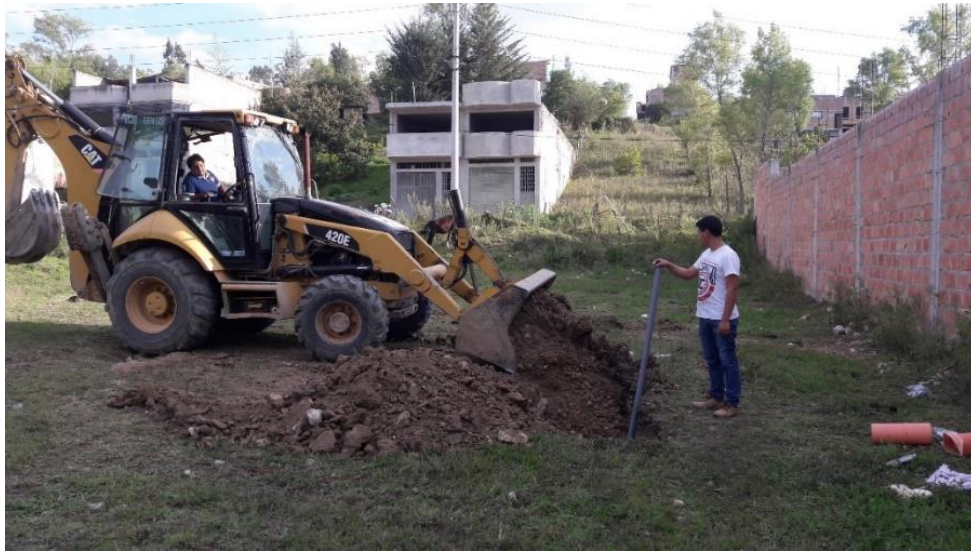
Fotografía N°09: Sellado de calicatas
